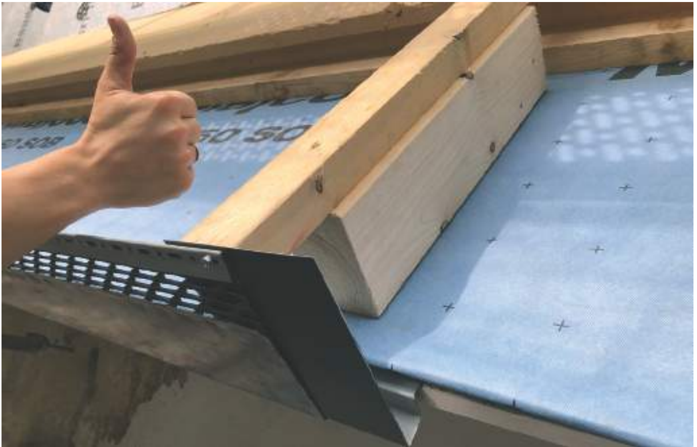
Ein neu entwickeltes Traufbelüftungsprofil enthält kaum sichtbare, integrierte Lüftungsöffnungen und ermöglicht die problemlose Entwässerung des Unterdaches.
