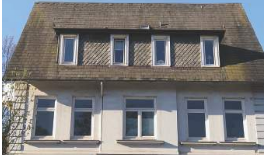
An dem 1880 errichteten Gebäude hielt die Dachkonstruktion einschließlich der Deckung den hohen Anforderungen an den Wetterschutz und der Energieeinsparung nicht mehr stand.
