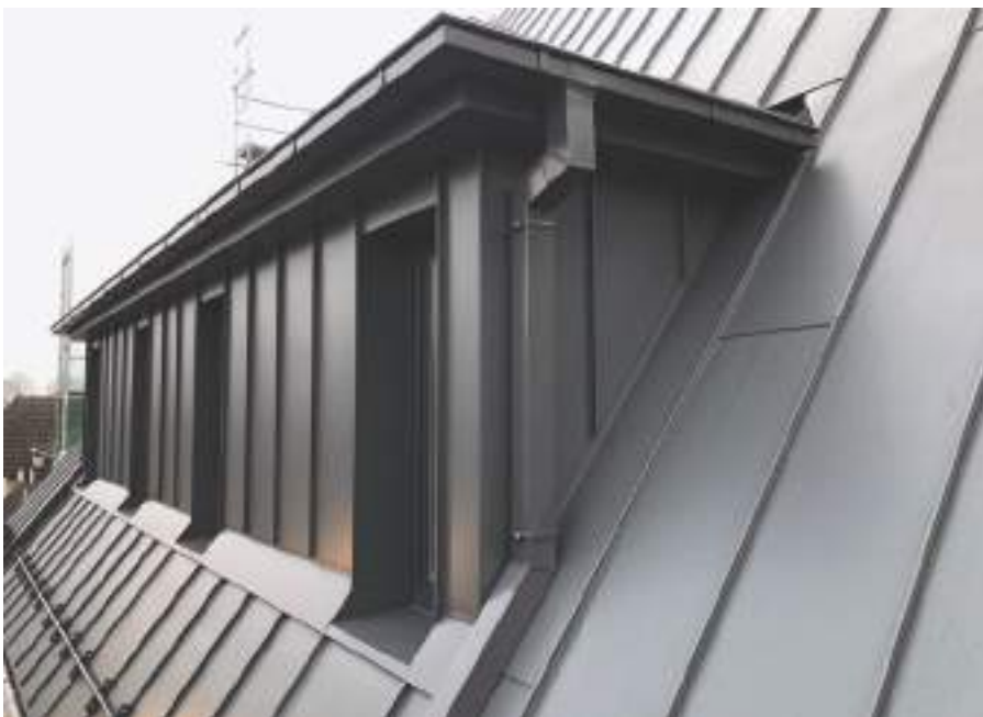
Das Ergebnis des hochwertigen Erscheinungsbildes dieser Gaubenbekleidung ist eine filigrane Planung und die präzise handwerkliche Ausführung jedes einzelnen Details.
